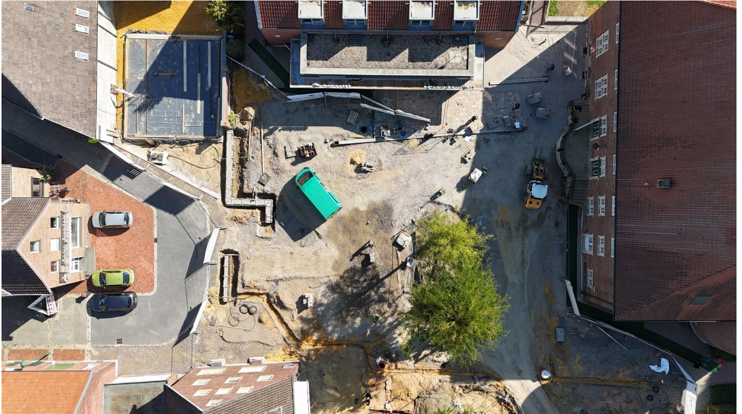
Bereich zwischen Umfahrung und Burg
