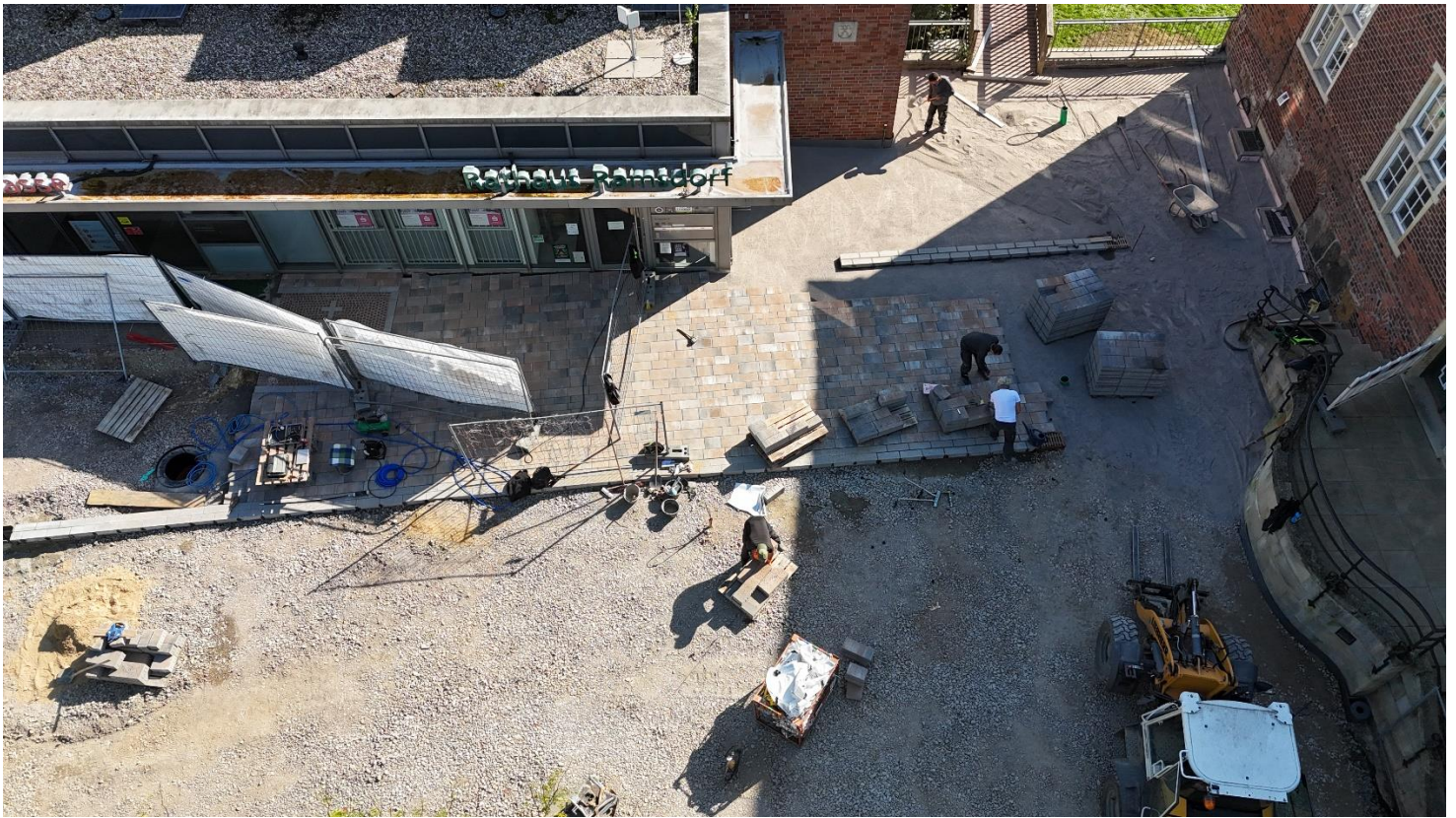
Pflasterarbeiten vorm Rathaus zur Burg hin
