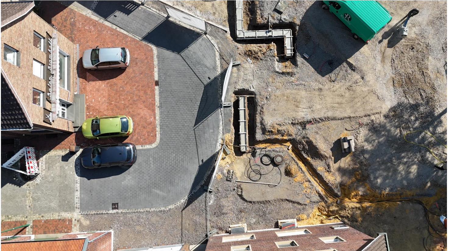
Fundamente für die Verlängerung der Mauer an der Sparkasse
