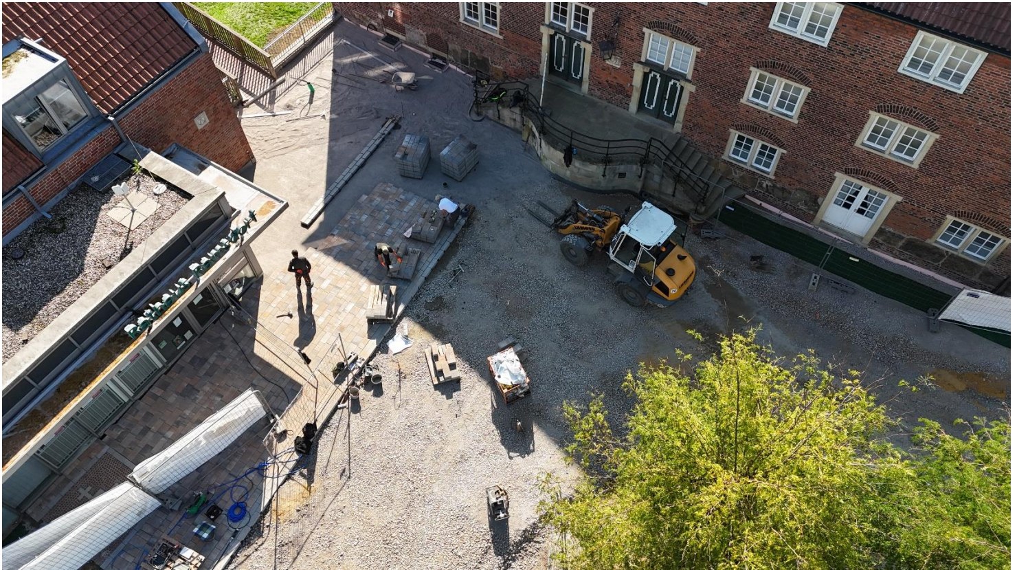
Pflasterarbeiten vorm Rathaus zur Burg hin
