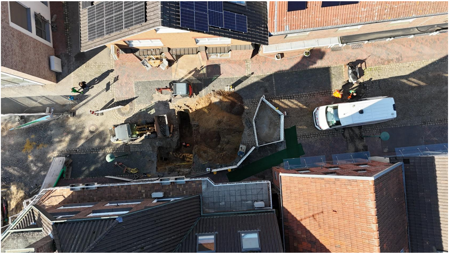
Letzte Arbeiten an den Hausanschlüssen in der Langen Straße
