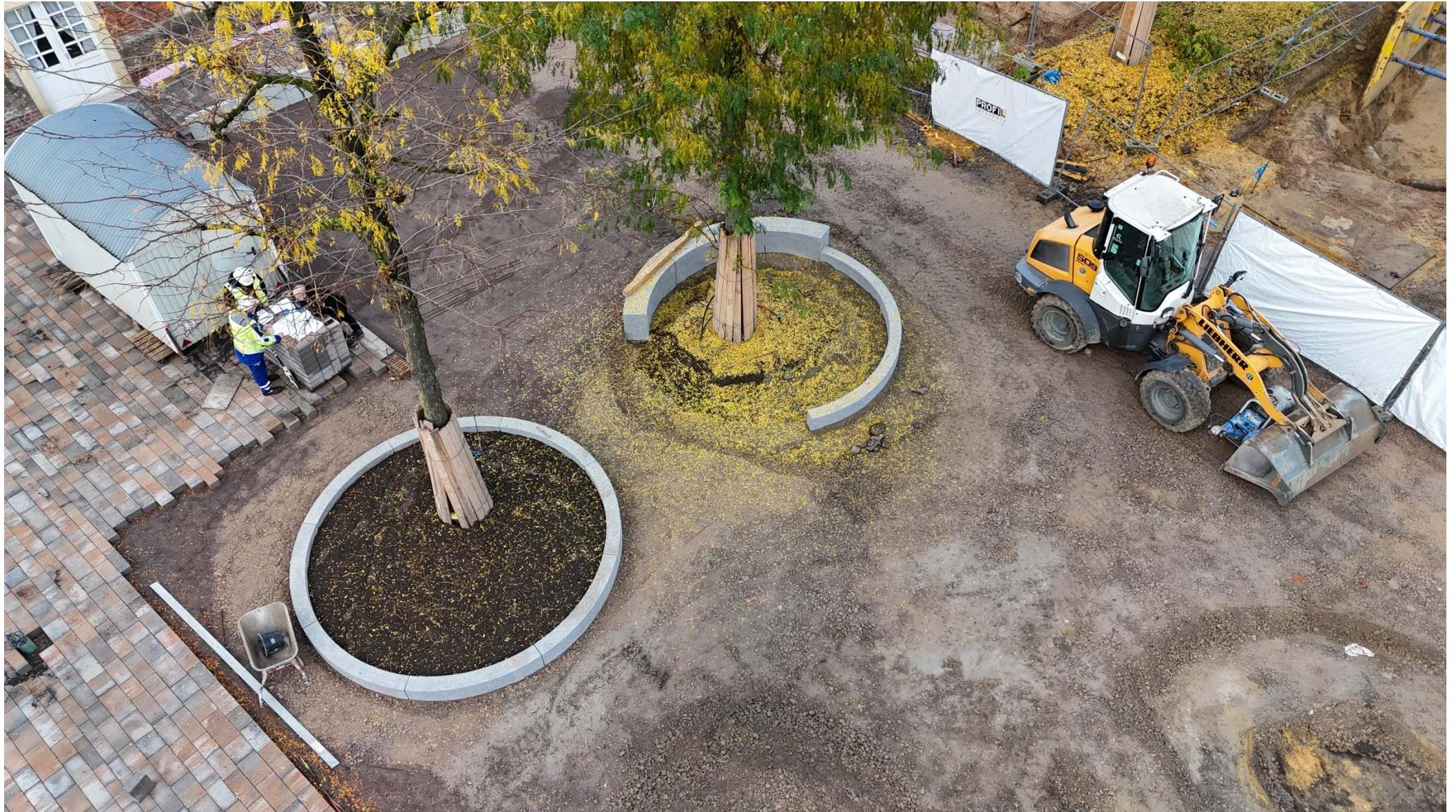
Fertigstellung der ersten Baumscheiben an den Bestandsbäumen; danach kann weiter angepflastert werden
