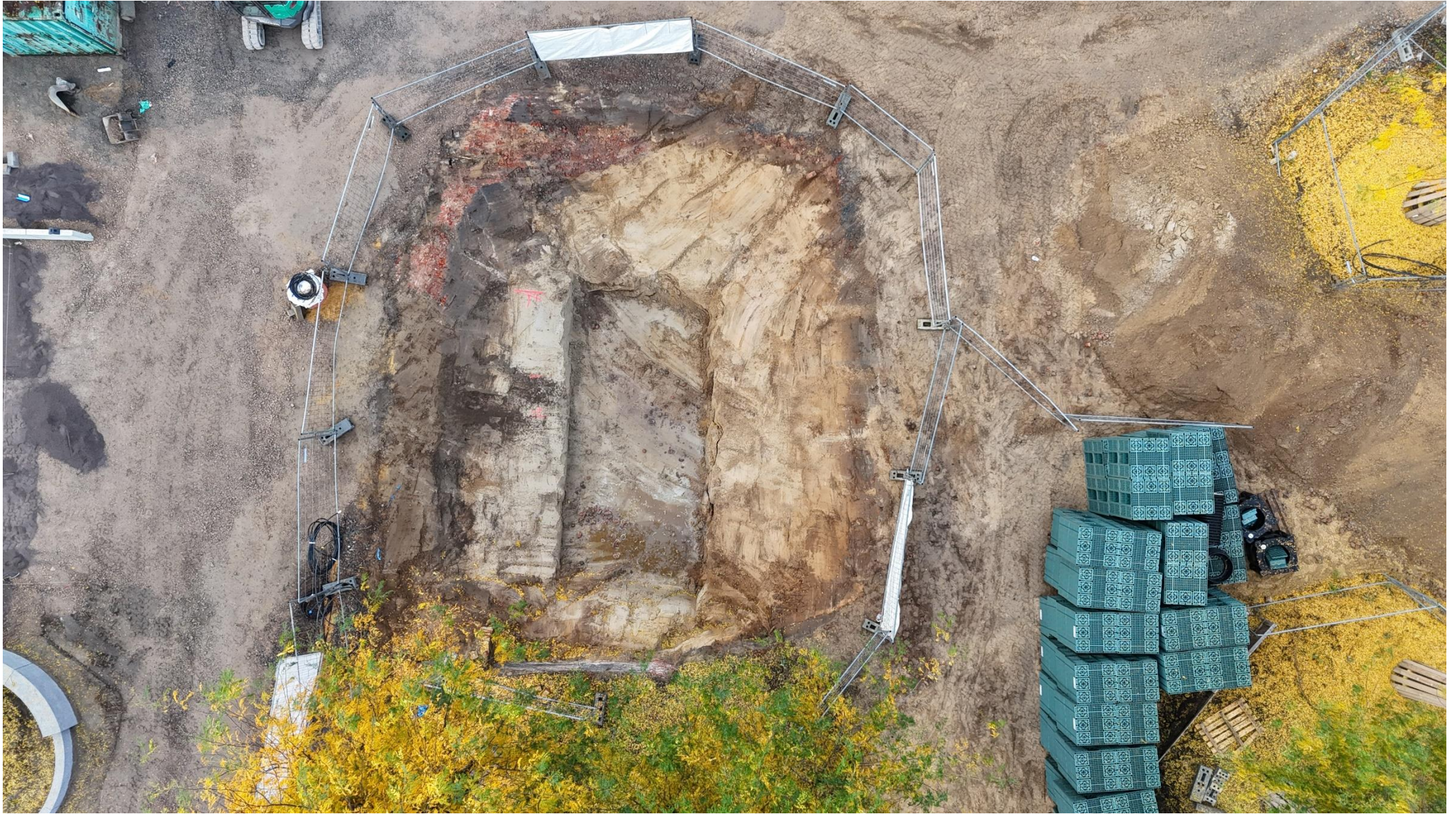
Baugrube für die Pumpenkammer mit der gesamten Technik für das Fontänenfeld; mit Böschung versehen, deswegen kein Verbau notwendig
