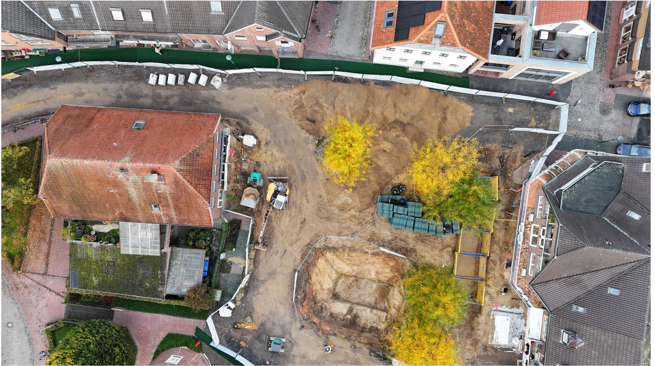
Auf der Langen Straße liegt der komplette Aushub der beiden Baugruben; größtenteils wird der Aushub wieder verfüllt, der Rest abgefahren
