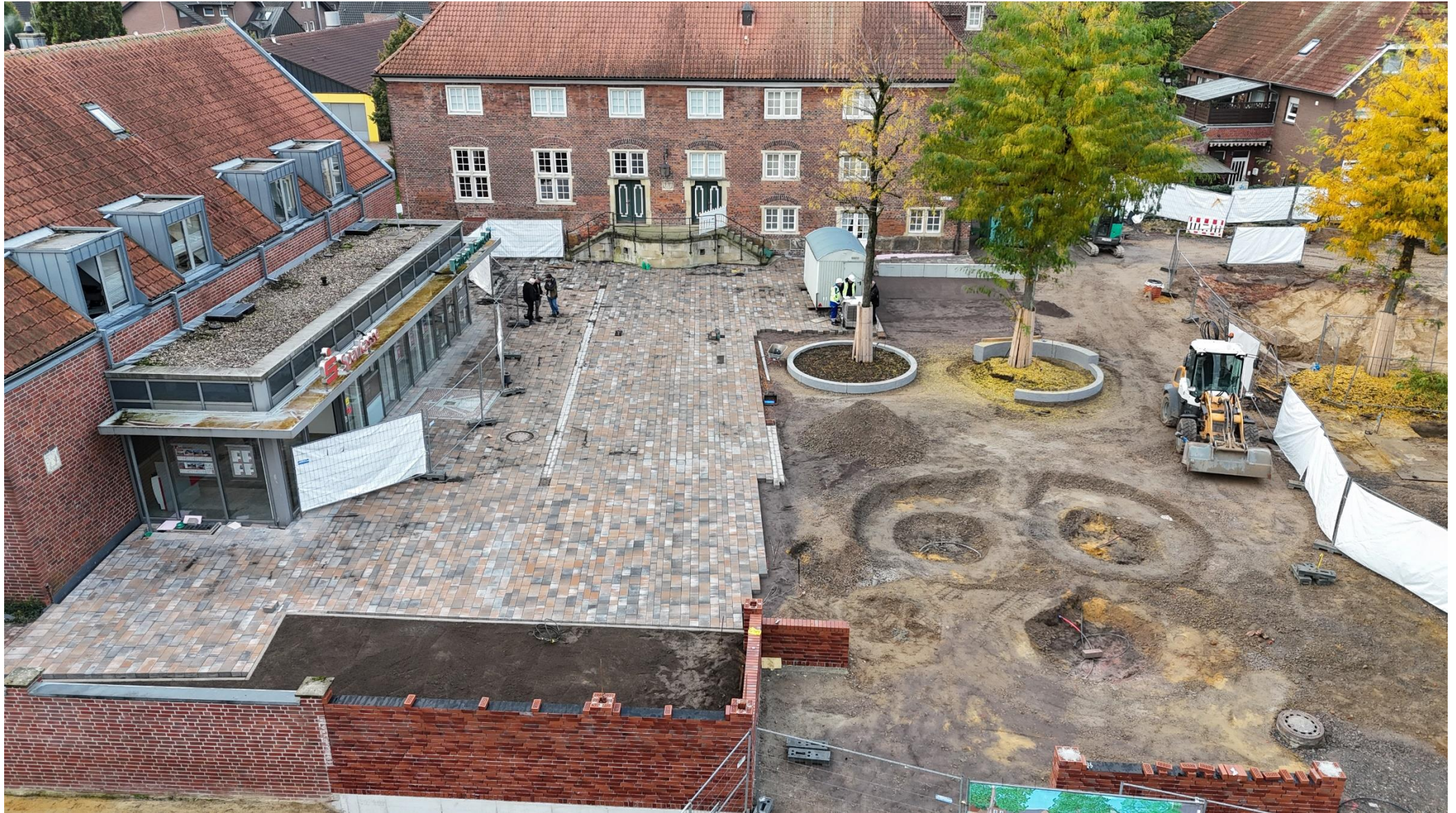
Gesamtüberblick Pflasterung, Mauer, Baumscheiben und neue Baumstandorte
