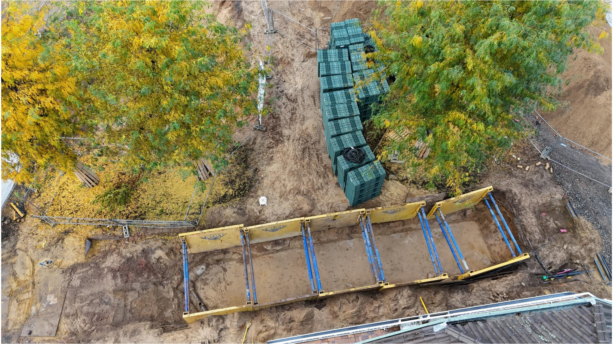
Verbau für den Bau der Zisterne; die grünen Kästen sind das Bausystem der Zisterne und werden mit Vlies und PVC-Ummantelung verschweißt
