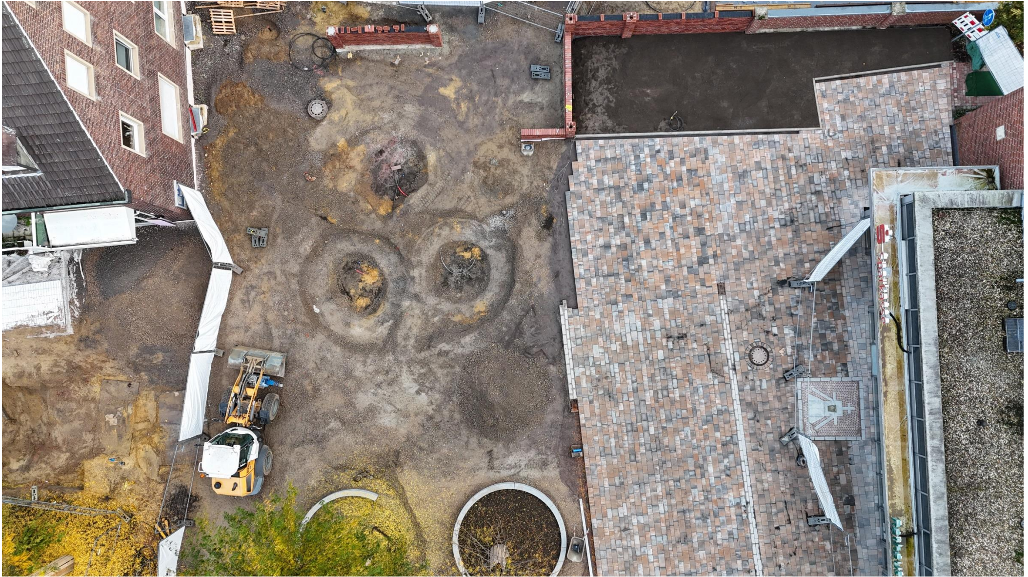
Fertigstellung der Mauer und des Grünbeetes sowie der drei neuen Baumstandorte
