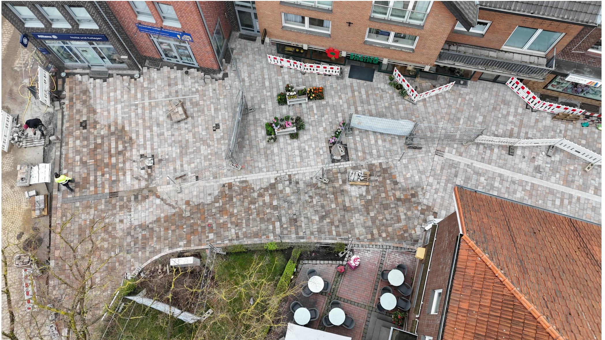
Vor dem Geschäft Ehling und der Allianzvertretung ist der Straßenbereich fertiggestellt; nur ein paar Anpflasterungen an den Gebäuden fehlen noch. Der Übergang zur alten Langen Straße, An der Gräfte und der Feuerwehreinfahrt ist teilweise hergestellt.
