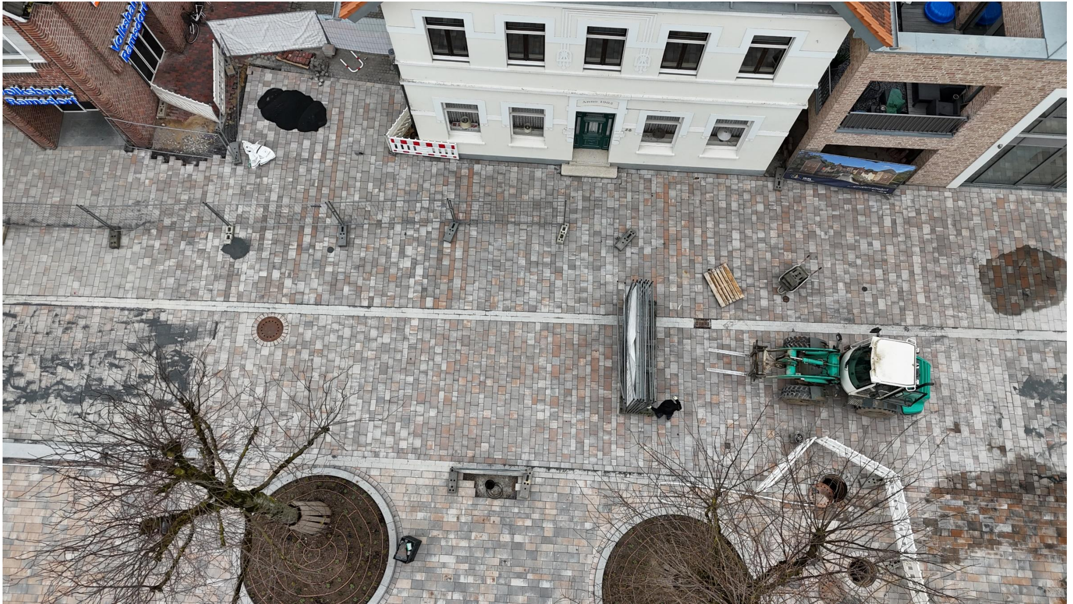
In Richtung Volksbank ist die Pflasterung der Langen Straße abgeschlossen.
