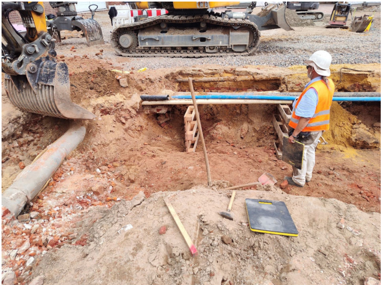
Abb. 11: Velen-Ramsdorf, Burgplatz Ramsdorf (MKZ 4107,0525); Arbeitsfoto von Schnitt 2, NO-Ecke (Foto: Salisbury Archäologie GmbH, S. Deiters).
