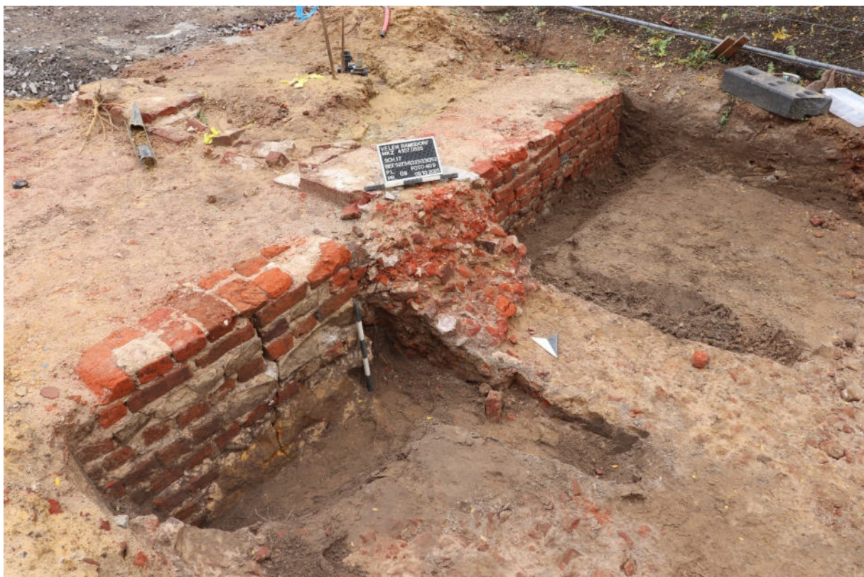
Abb. 33: Velen-Ramsdorf, Burgplatz Ramsdorf (MKZ 4107,0525); Blick von Norden auf das Widerlager mit jüngerem Ausbau und Steinraubgrube der Barbakane im Vordergrund/vorne rechts. Deutlich ist der Setzungsriss in den unteren Mauerlagen, bei dem selbst massive Natursteine zerplatzt sind. Dagegen sitzt die jüngere Mauerlage auf, von der aus Mörtel in den Riss hineingeflossen ist. (Foto: Salisbury Archäologie GmbH, A. van Lochum).
