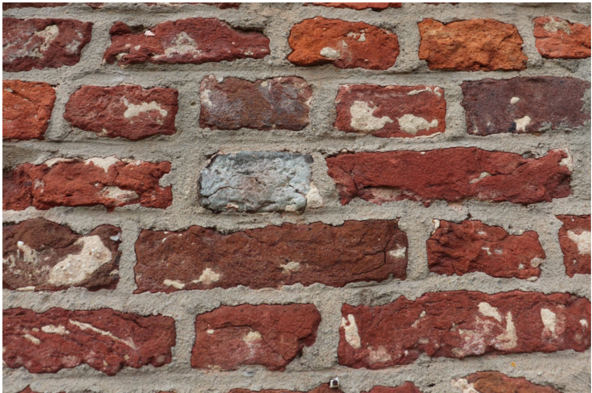
Abb. 22: Velen-Ramsdorf, Burgplatz Ramsdorf (MKZ 4107,0525); Foto mit Ausschnitt der Südostwand des bestehenden Burggebäudes. In der Mitte ein typischer glasierter Ziegel der 1. Bauphase (Foto: Salisbury Archäologie GmbH, G. V. Grimm).
