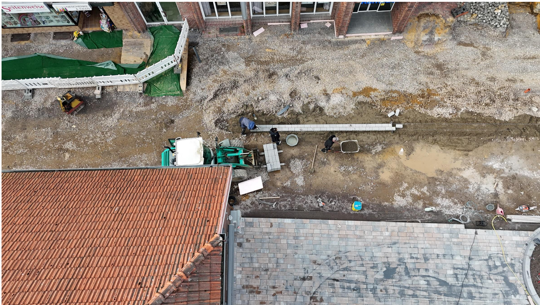
Die Entwässerungsrinne in der Mitte der Langen Straße wird hergestellt, so dass am Freitag und Samstag der südliche Anschluss an den Marktplatz gepflastert werden kann. Der Gehweg entlang der Geschäfte von der Allianz bis zum Buchladen Seitenweise ist wieder hergestellt.
