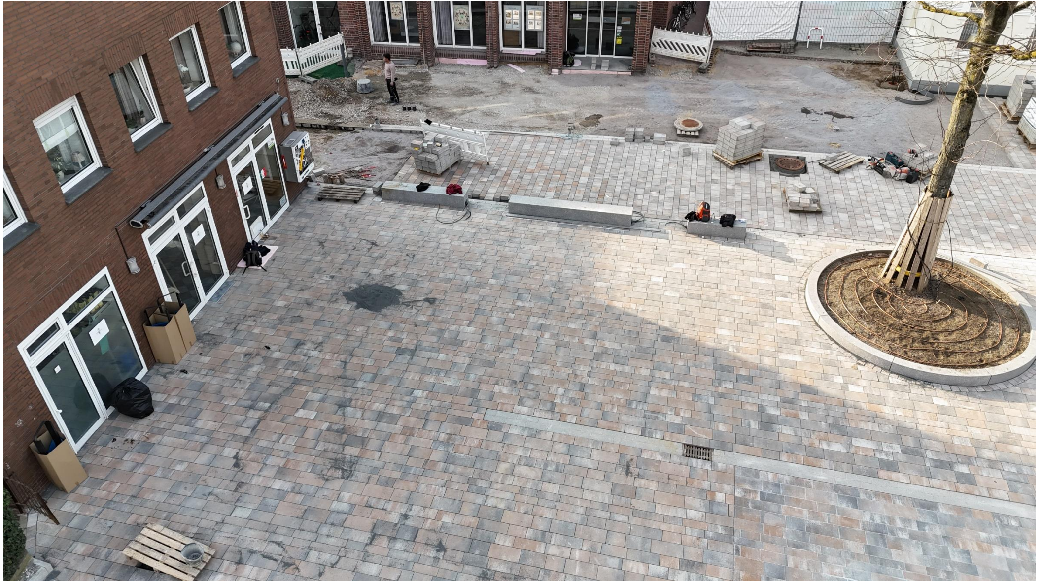
Die Sitzblöcke vor dem Rathaus und vor der Eisdielen sind gesetzt und werden noch mit einer Holzauflage und einer Beleuchtung versehen. Die Holzauflage kommt auch auf die erhöhten Baumscheiben.
