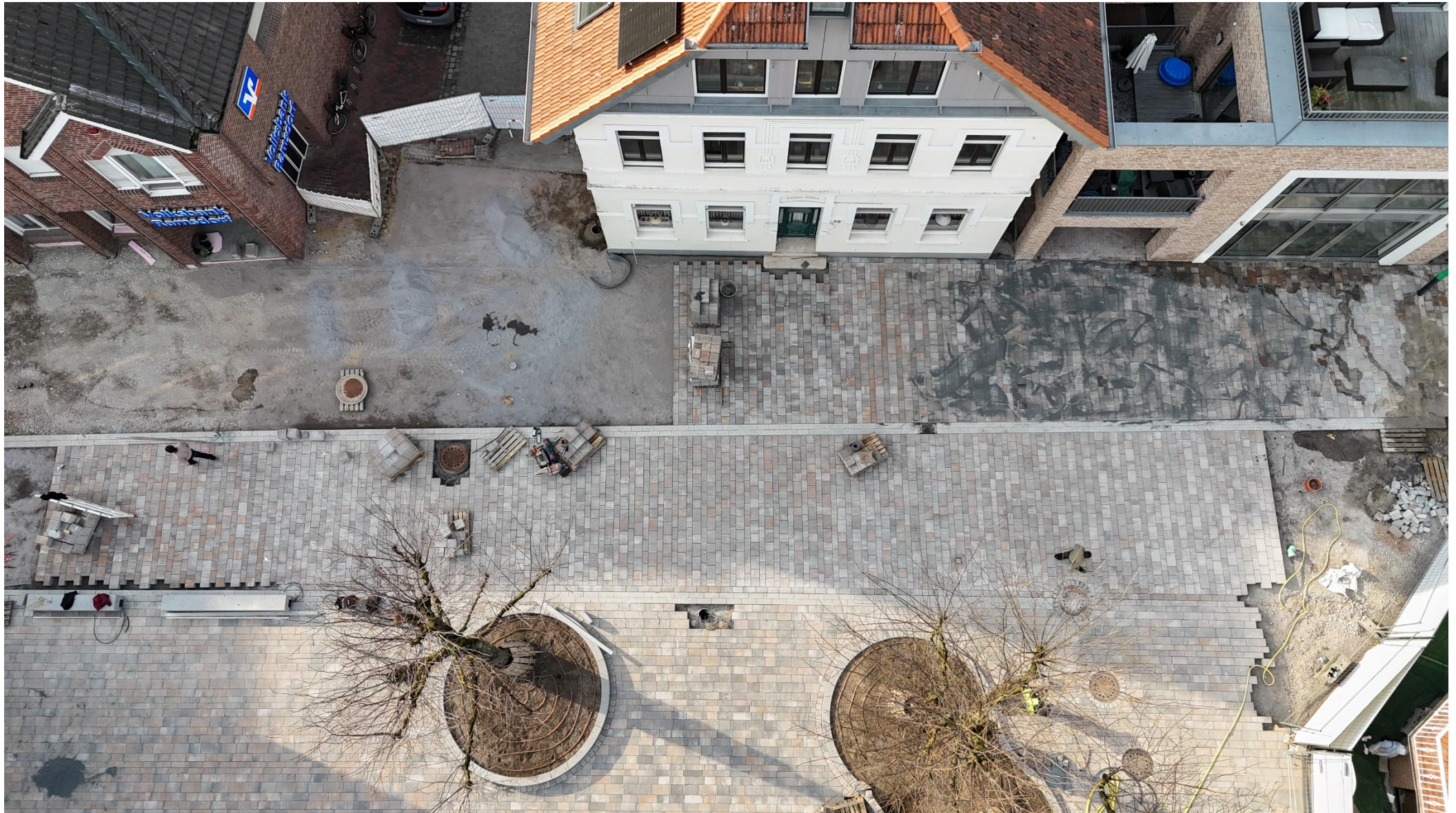
Das Pflaster ist bis kurz vor der Einfahrt Hüpohl fertiggestellt. In dieser Woche wird in Richtung Volksbank weiter gepflastert. Die Bewässerungstechnik in den Baumscheiben ist angelegt.
