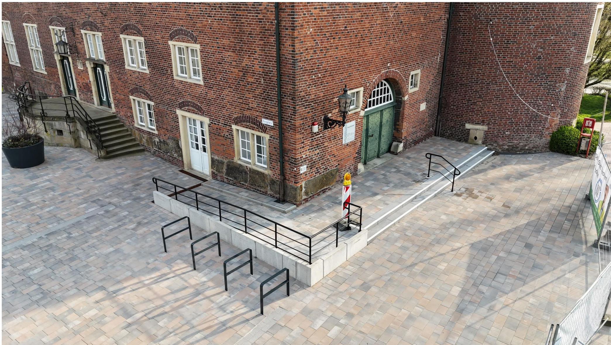
Das neue Geländer an der Burgrampe sowie der Handlauf vor dem Burgeingang ist heute installiert worden.
