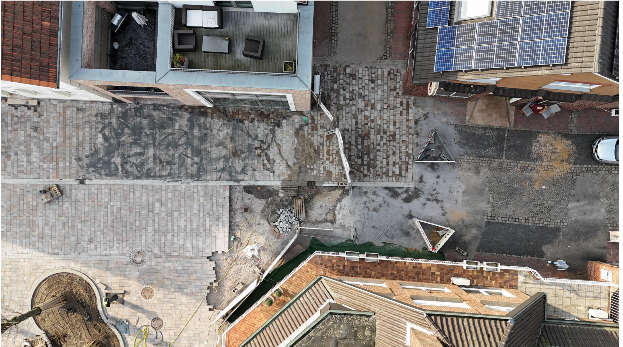
Vor der Bäckerei Kremer ist die einseitige Pflasterung der Langen Straße abgeschlossen worden, so dass die Durchfahrt mit dem PKW in die Josefstraße wieder frei gegeben werden konnte. Die andere Seite zum Fußweg bei Kipp wird folgen; danach kann der gesamte Bereich freigegeben werden.
