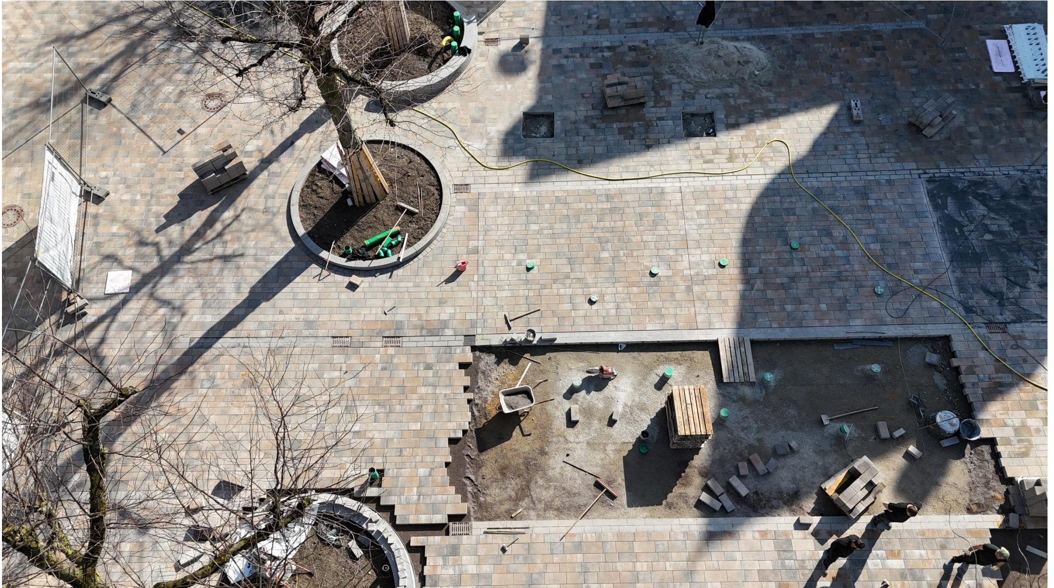
Der obere Teil des Fontänenfeldes konnte in dieser Woche bei gutem Wetter gepflastert werden; der untere Teil wird in der nächsten Woche hergestellt; die Pflasterung um das Fontänenfeld ist weitestgehend hergestellt.
