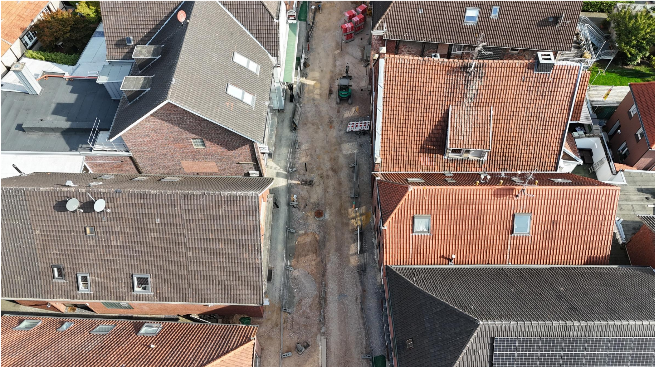
Die Rinne in der Mitte der Langen Straße ist bis zur Hälfte schon gesetzt und wird in den nächsten Wochen bis zur Hausstraße verlängert.
