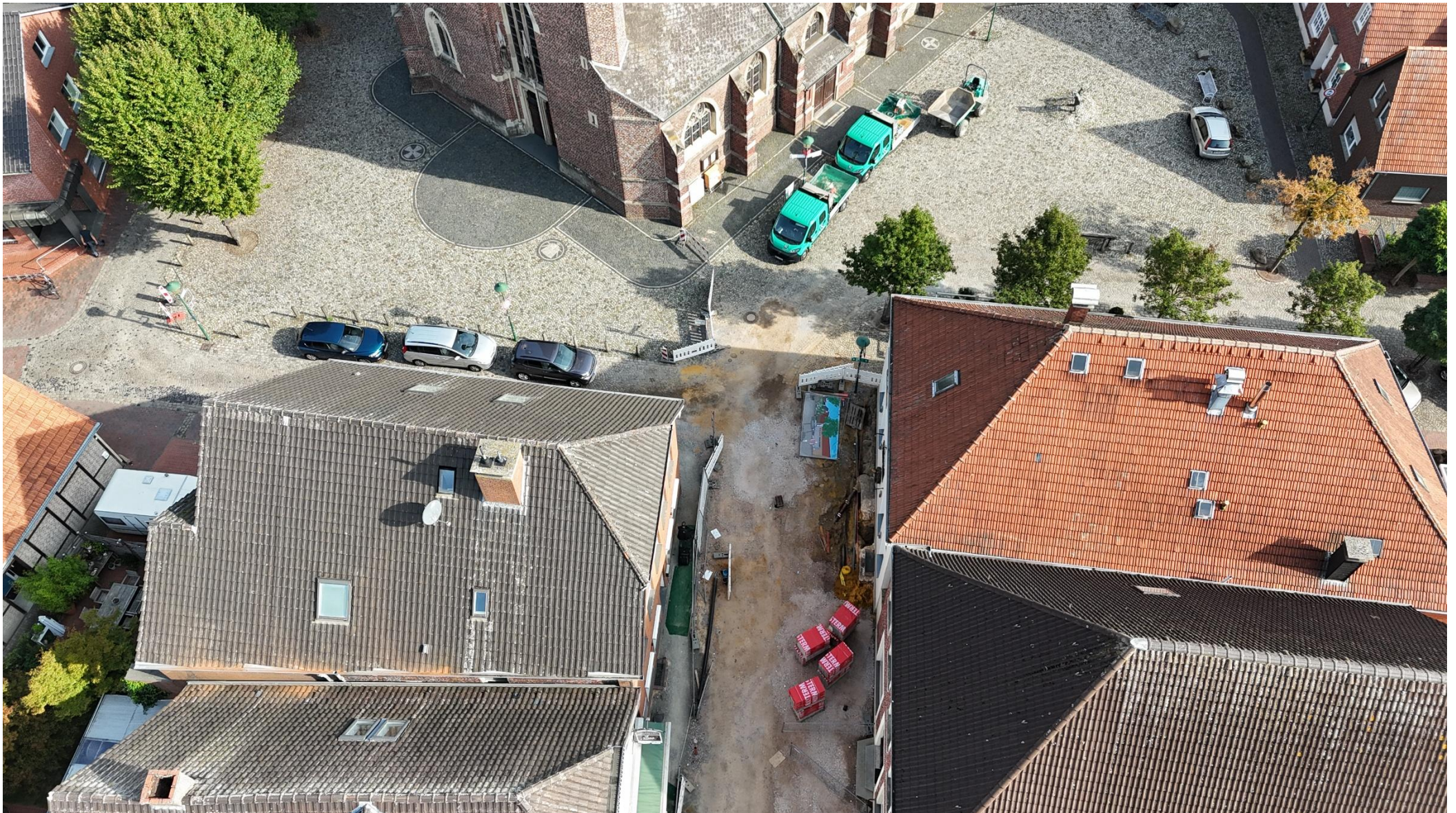
Am Ende der Langen Straße wird das neue Pflaster an die Hausstraße angeschlossen für den 3. Bauabschnitt.
