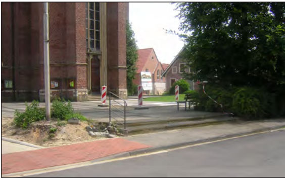
Früherer Zustand Kirchplatz
