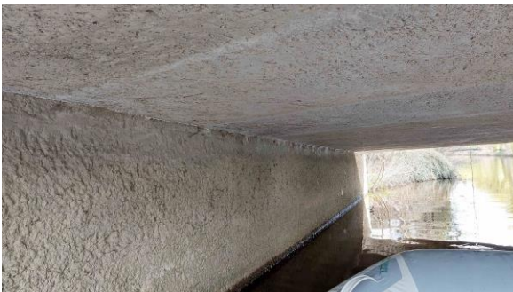
Ansicht Widerlager Nord von Südwest
