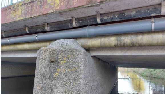
Ansicht Pfeiler von Südwest
