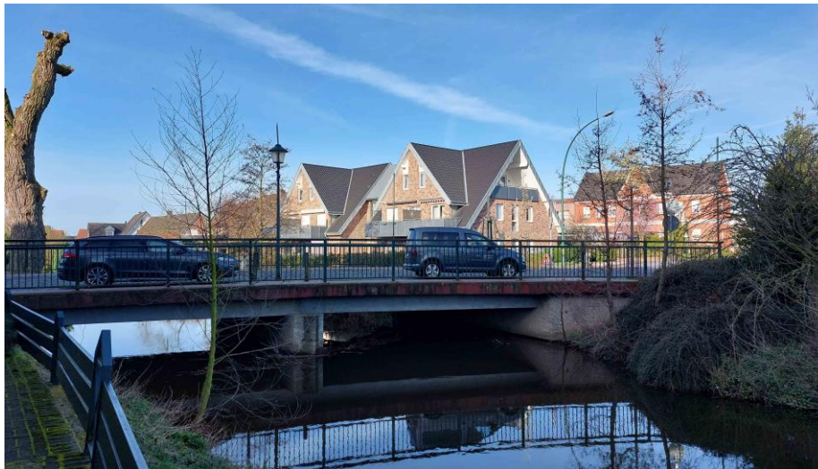
Ansicht von Osten
