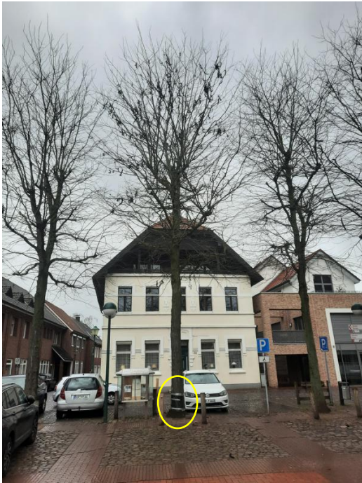
Abbildung 9: Anfahrtschadensversorgung an Baum Nr. 23
