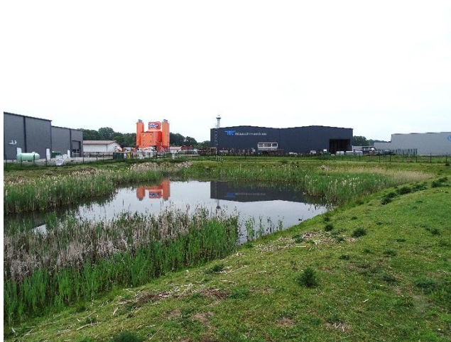
Abbildung 11: Regenrückhaltebecken bestehenden Gewerbegebiet.
