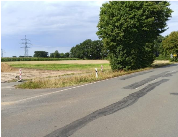
Foto V: Schwenk nach Westen über Wesecker Straße
