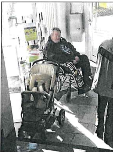
fehlende Barrierefreiheit im Eingangsbereich
