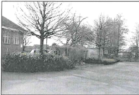
Trasse der geplante Überquerung der Bocholter Aa Ortskern - neuer Nahversorger, Grundstück mit "Altem Schlachthof" (Gebäude links im Bild).
