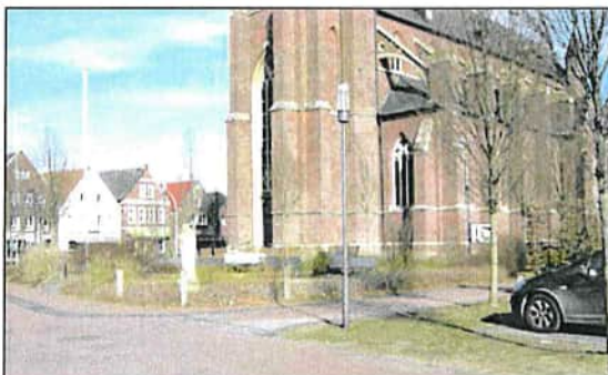
Heute: Kirchplatz nach dem Gebäude Rückbau
